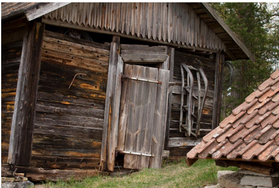
Pedassaare Kaarli talu laevaplankudest kuur. Foto: Toomas Tuul
