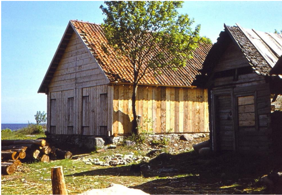
Altja Sagadi mõisa paadikuuri taastamine. Paremalt näha ajalooline kalasabatapiga ja aknaga kuur tõenäoliselt 30ndate lõpust. 23.05.1972. Foto: Arne Kaasik
